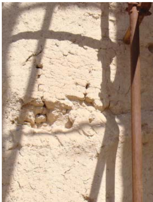
تصویر ۱۵. بخشی از تصویر ۲ که خط قطع کاربرد آجر پایین مناره و دو خط نشانه از اتصالات از میان رفته به بنا را نشان می دهد.
