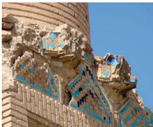
تصاویر ۲۰ و ۲۱. جزئیات قطاربندی آجر کاشی در لبه بام نظامیه (تصویر بالا) و مشابه آن در گنبد سلطانیه زنجان (تصویر پایین) (نگارنده)
