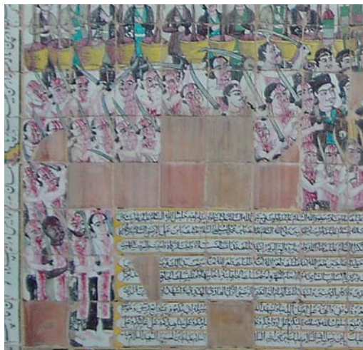
تصویر ۶: تکیه معاون الملک، ترمیم کمبودها با کاشی بدون لعاب (حمید فدایی)
