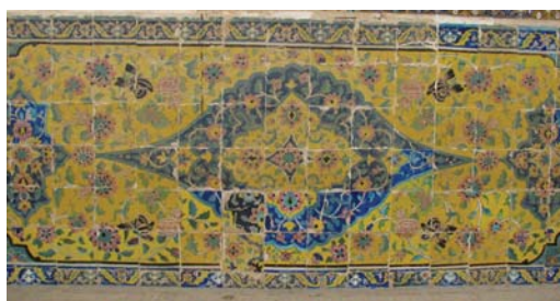
تصویر ۲. مسجد امام، سمنان، تکمیل کمبودها با کاشی‌های جدید که از نظر مایه و شدت رنگ اندکی متفاوت هستند (نگارنده).
