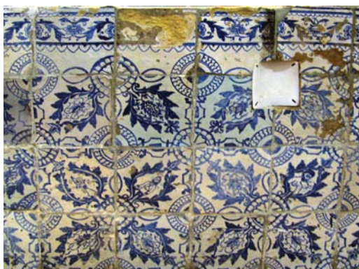
تصویر ۹. حمام پهنه سمنان، کاشیکاری جدید (راست) وفادار به فضای رنگی اصلی و با تنوع کمتر در نقوش در قیاس با کاشی های اصلی (چپ) اجرا شده است (نگارنده).
